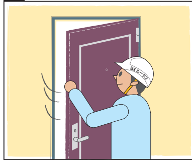
新設扉および金物を取り付け、調整を行います
