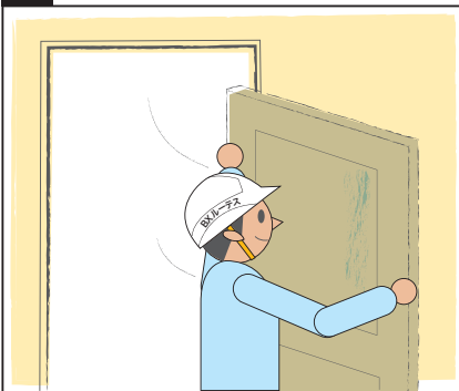
既存扉を撤去し、養生を行います
