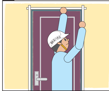
枠の周りにシーリングを施し、雨水の侵入を防ぎます
