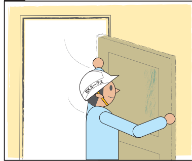
既存扉を撤去し、養生を行います
