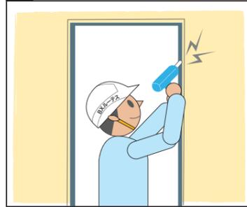
下地の取り付け後、新規枠を取付けます
