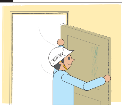
既存扉を撤去し、養生を行います
