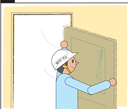
既存扉を撤去し、養生を行います
